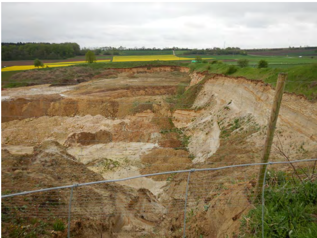
Überblick in Sandgrube, von Osten aus (betroffener Teil im Hintergrund)
